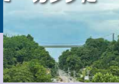
完成間近の呉羽山連絡橋
