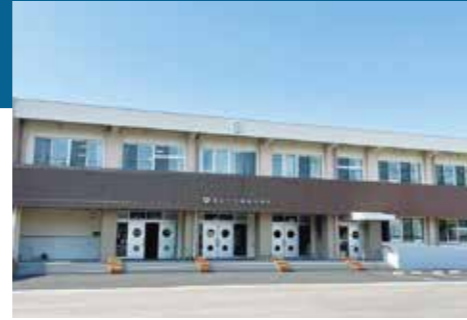
1期工事終了し、2期工事工事中の富山市立西部中学校
